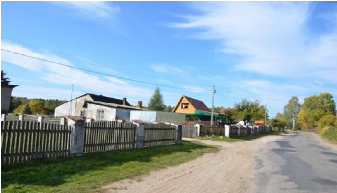
Część starej zabudowy wsi. Widok drogi wojewódzkiej nr 508
